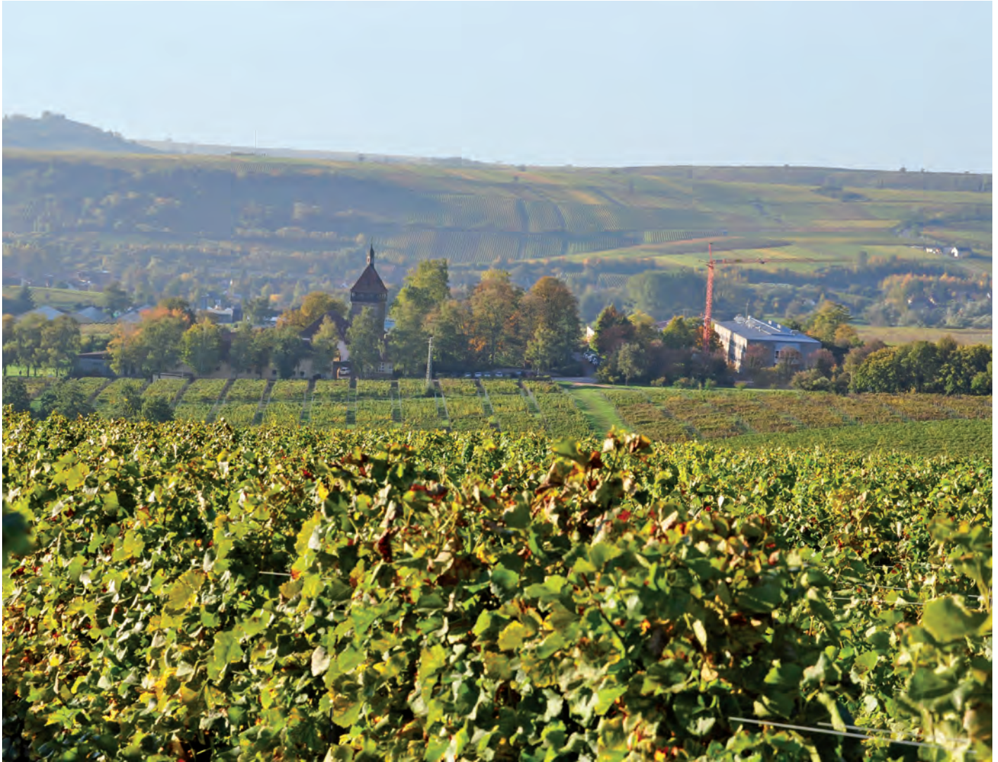
Der Geilweilerhof eingebettet in die Landschaft des Queichtals am 11.10.2010. Der Kran markiert die Baustelle des zukünftigen Gewächshauses des Instituts für Pflanzenschutz im Weinbau. (Foto: JKI)
