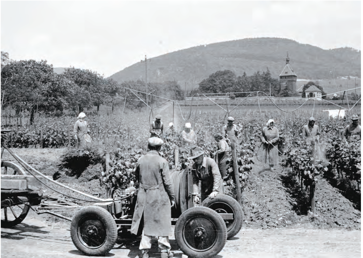
Spritzkolonne mit zentraler Pumpe für Pflanzenschutzmittel.
