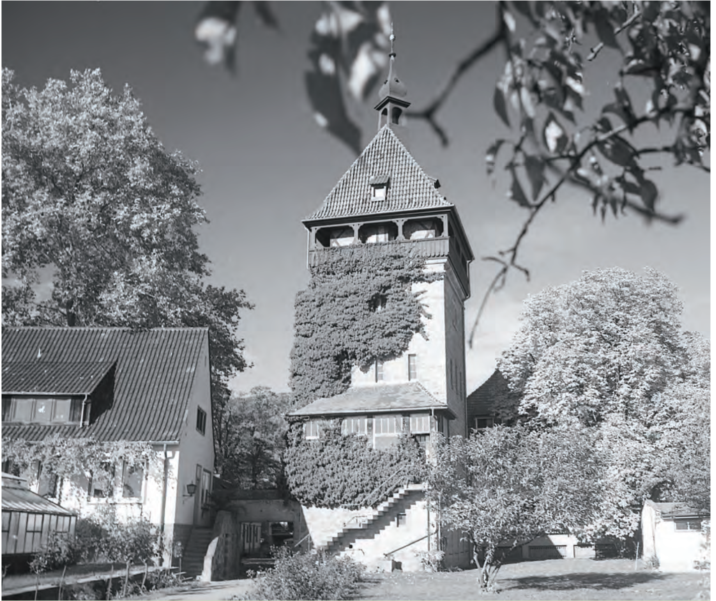
Von Efeu eingewachsener Turm des Geilweilerhofs Mitte der 1970er Jahre. Mehrfach wurde der Efeu zurückgeschnitten und gebändigt. Anfang der 2000er Jahre musste er dann endgültig weichen, da er Schäden an der Bausubstanz verursachte. (Foto: JKI)
